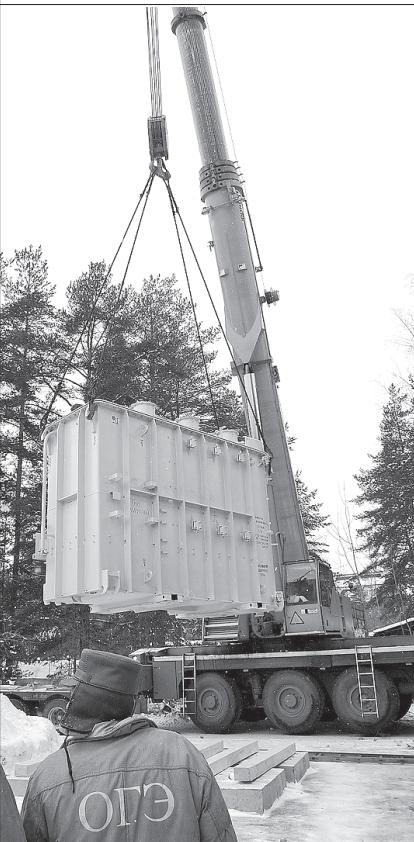
В конце января Отделом главного энергетика ОИЯИ получен четвертый силовой трансформатор, понижающий напряжение со 110 до 10 кВ, для ГПП-2 (площадка ЛЯП). Напомним, что третий трансформатор на этой подстанции был введен в эксплуатацию в прошлом году. С вводом четвертого мощность подстанции удвоится, повысится стабильность электроснабжения, что положительно скажется на потребителях не только площадки ЛЯП, но и правобережной части города.
